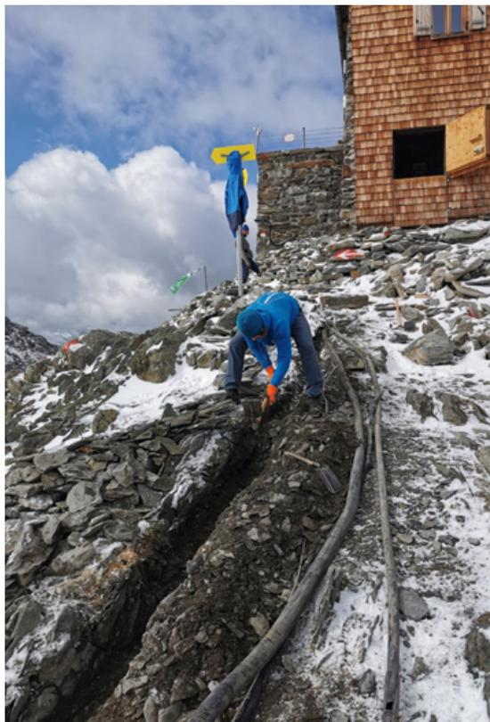
So stehen wir beizeiten auf und erörtern nach einem ausgiebigen Frühstück die Lage vor Ort. Es hat geschneit. Wir suchen den Kanalverlauf der Leitungen, legen diese zunächst frei und stellen fest, dass das alte Steuerkabel, welches nach der Erneuerung des Dieselaggregates nicht mehr gebraucht
